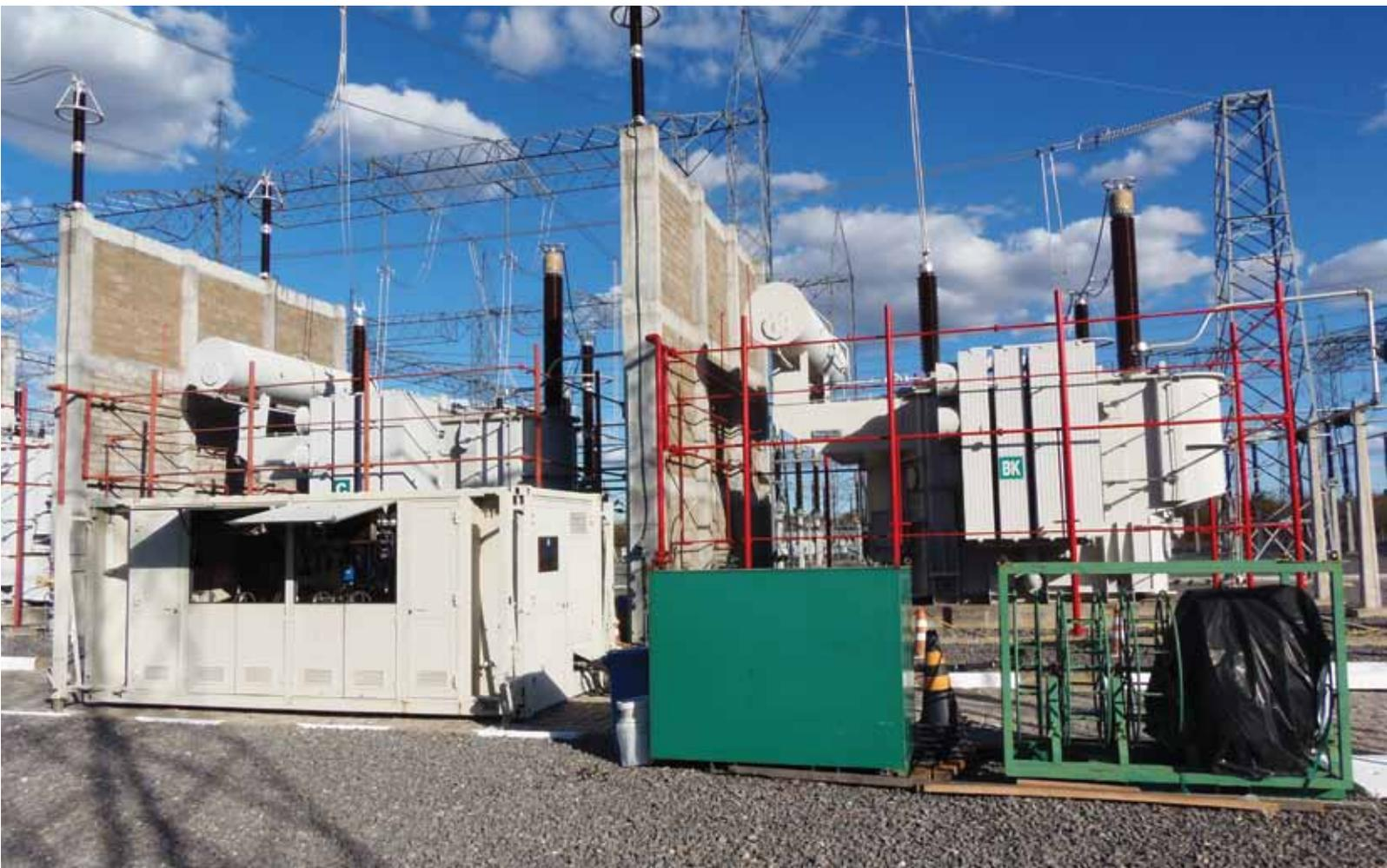
autotransformadores monofásicos e um reator de alta tensão, todos com nível de tensão de 500 kV e com óleo contaminado.
