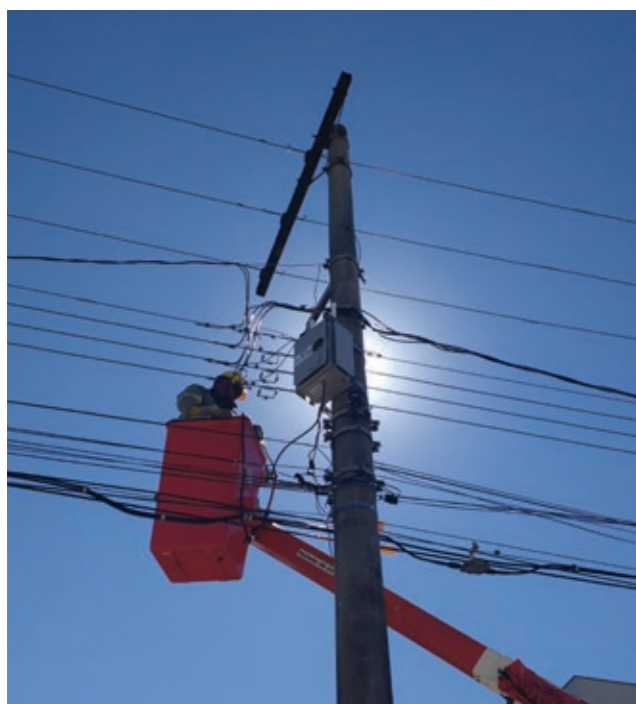
Funcionário instalando Rede de Comunicação Híbrida
