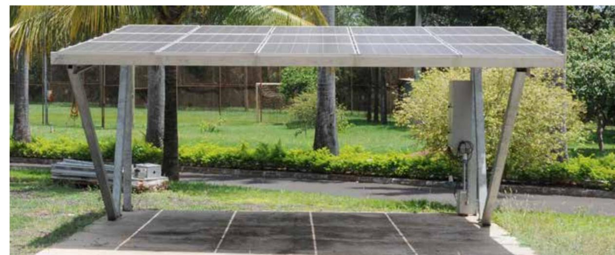
Garagem para recarga de veículo elétrico com microgeração fotovoltaica instalada na unidade da Cemig de Uberlândia, no Triângulo Mineiro
