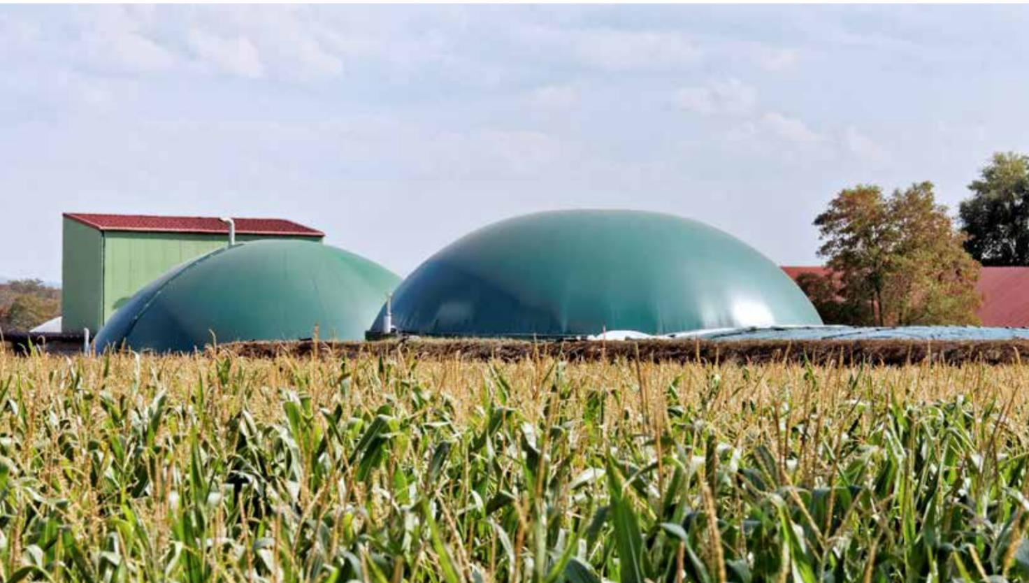
Os biodigestores são compartimentos fechados nos quais ocorre decomposição de matéria orgânica, produzindo biogás e biofertilizante
